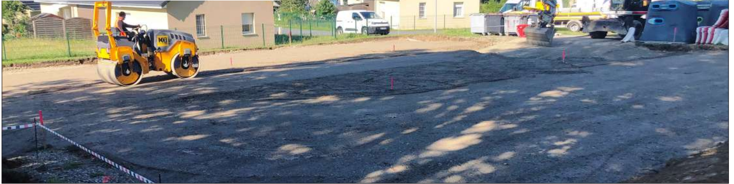
Goudronnage du parking de l'école. Projet d'aménagement du bourg. Travaux financés par la commune.
