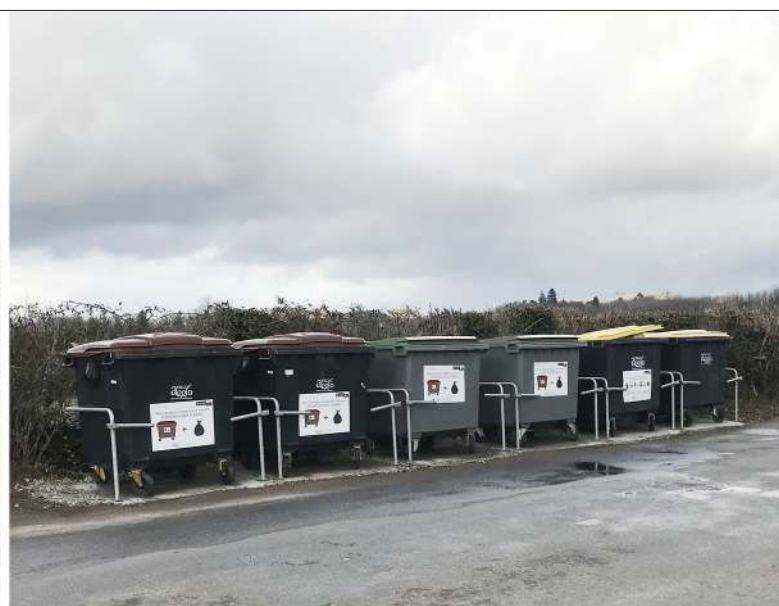
Réalisation d'une plateforme en béton pour les containers à poubelles route du Peuch.
