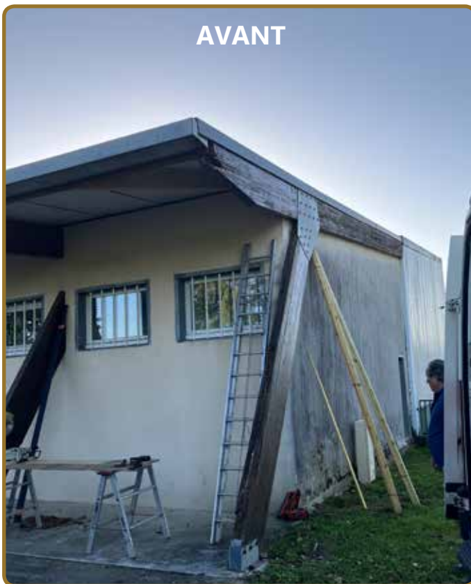
Consolidation et protection des solives de la salle Culture-Loisirs.
