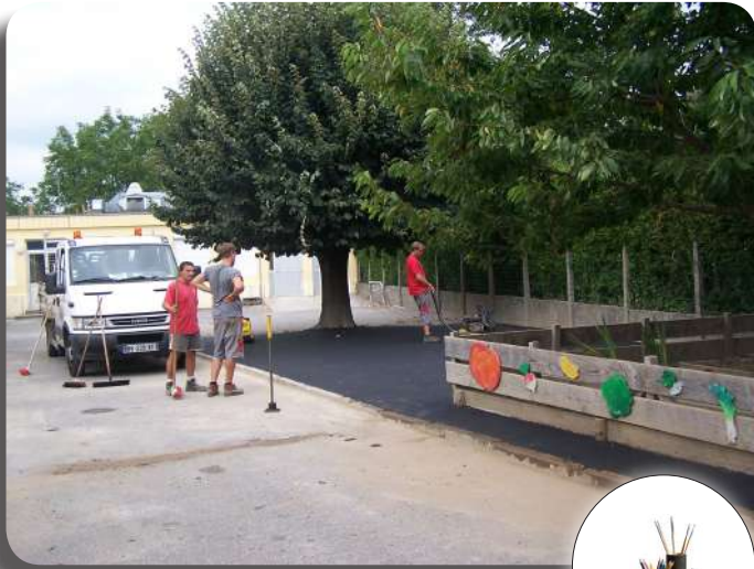
Travaux cour d'école
