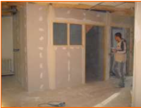
Travaux à la micro-crèche « Les Petits Loups » Pose placo-plâtre
